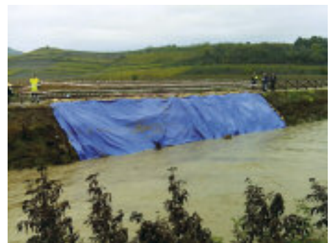
Una stazione di monitoraggio e la piena del torrente Alpone: sacchi di sabbia e telo plastificato sono stati posizionati per evitare l'erosione della sponda.
